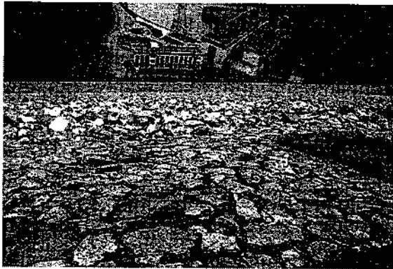
图 6 紫坪铺大坝下游坡面砌石松动和翻起现象
